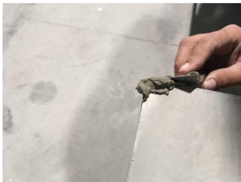
Foto: Beispiele für die Anwendung der Reparaturmasse
