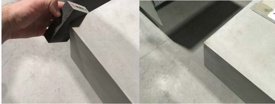
Foto: Beispiel für das zusätzliche Schleifen der reparierten Stelle und ihr endgültiges Aussehen.
